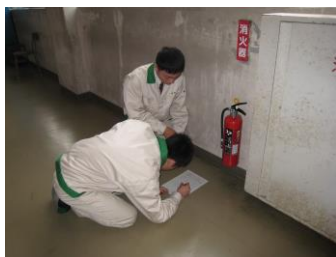
消火器設備の確認
