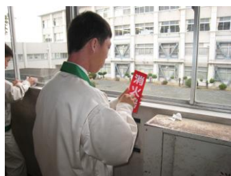
消火器表示板の修理
